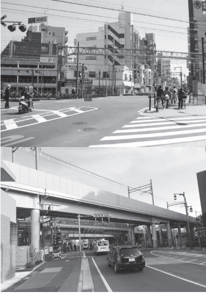
開かずの踏切【上】平成17(2005)年3月撮影 【下】令和3(2021)年3月撮影
